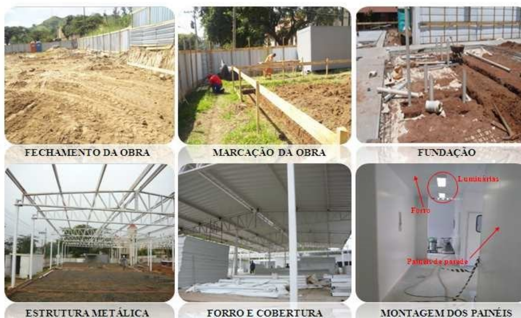
Figura 5 – Processo Construtivo do Centro Vocacional de Barra mansa (CVT Barra Mansa)
