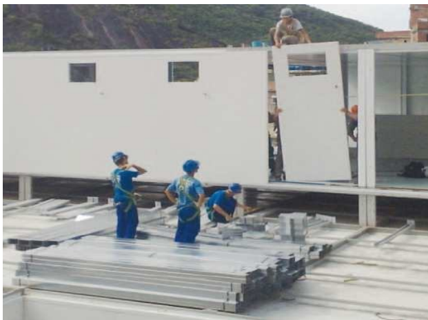
Figura 4 - Montagem dos elementos no local.
