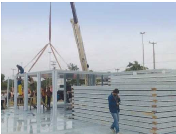
Figura 3 - Transporte e montagem dos módulos
