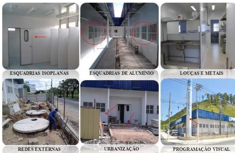
Figura 6 - Processo Construtivo do Centro Vocacional de Barra Mansa. (CVT Barra Mansa)
