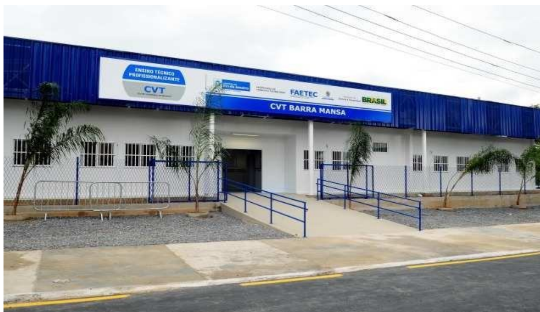
Figura 7 - Obra concluída – CVT Barra Mansa.
